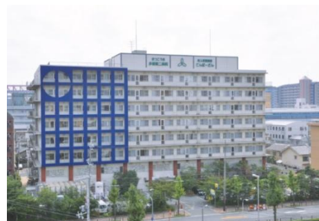
(写真の3階～6階が多根第二病院病棟)
